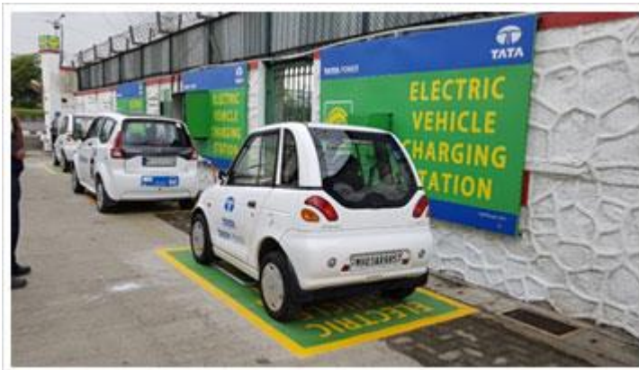
Tata PowerのEV充電ステーション（MH州Mumbai）
